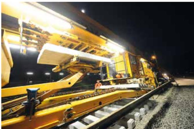
Der SUZ (Schnellumbauzug) verlegt Schienen und Schwellen,
